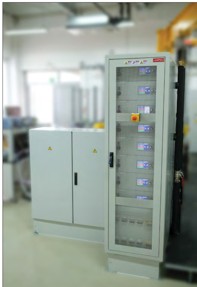
Enosmerni napajalni sistem in DC/AC pretvornik moči 240 kW
