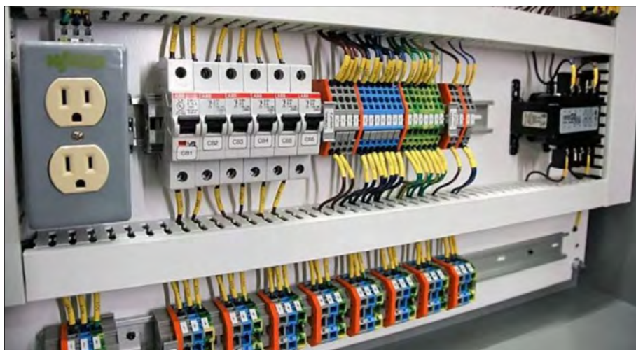
Slika 1: Industrijska omarica z različnimi tipi modulov, nameščenih na DIN-tirnicah, omogoča enostavno namestitev in odstranitev modulov s sprednje strani ter hiter dostop do ožičenja. (Vir slike: Hackaday)
